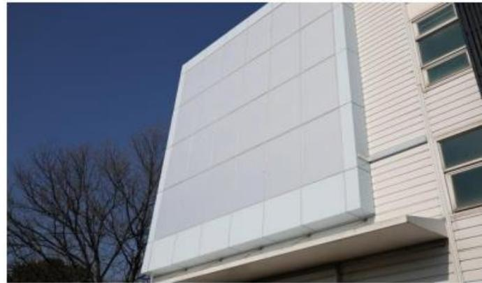
▲ 신성이엔지 BIPV, 슬라스킨 제품 설치 사진
